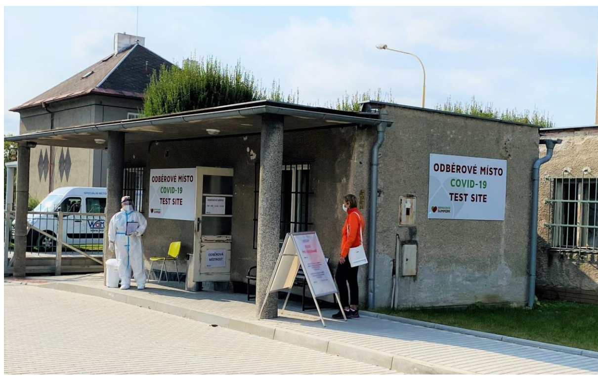
FOTO: Odběrové místo se nachází mezi nově zrekonstruovaným pavilonem P a pavilonem F. Autor: Hana Hanke, Archiv Nemocnice Šumperk
