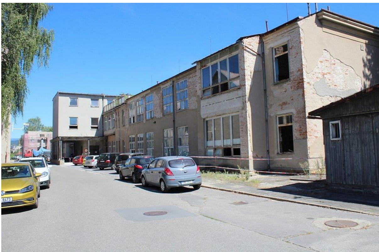
FOTO 3: Objekt byl původně v majetku Města Šumperk, na svou rekonstrukci si musel počkat přes 20 let. Autor: Archiv Nemocnice Šumperk
