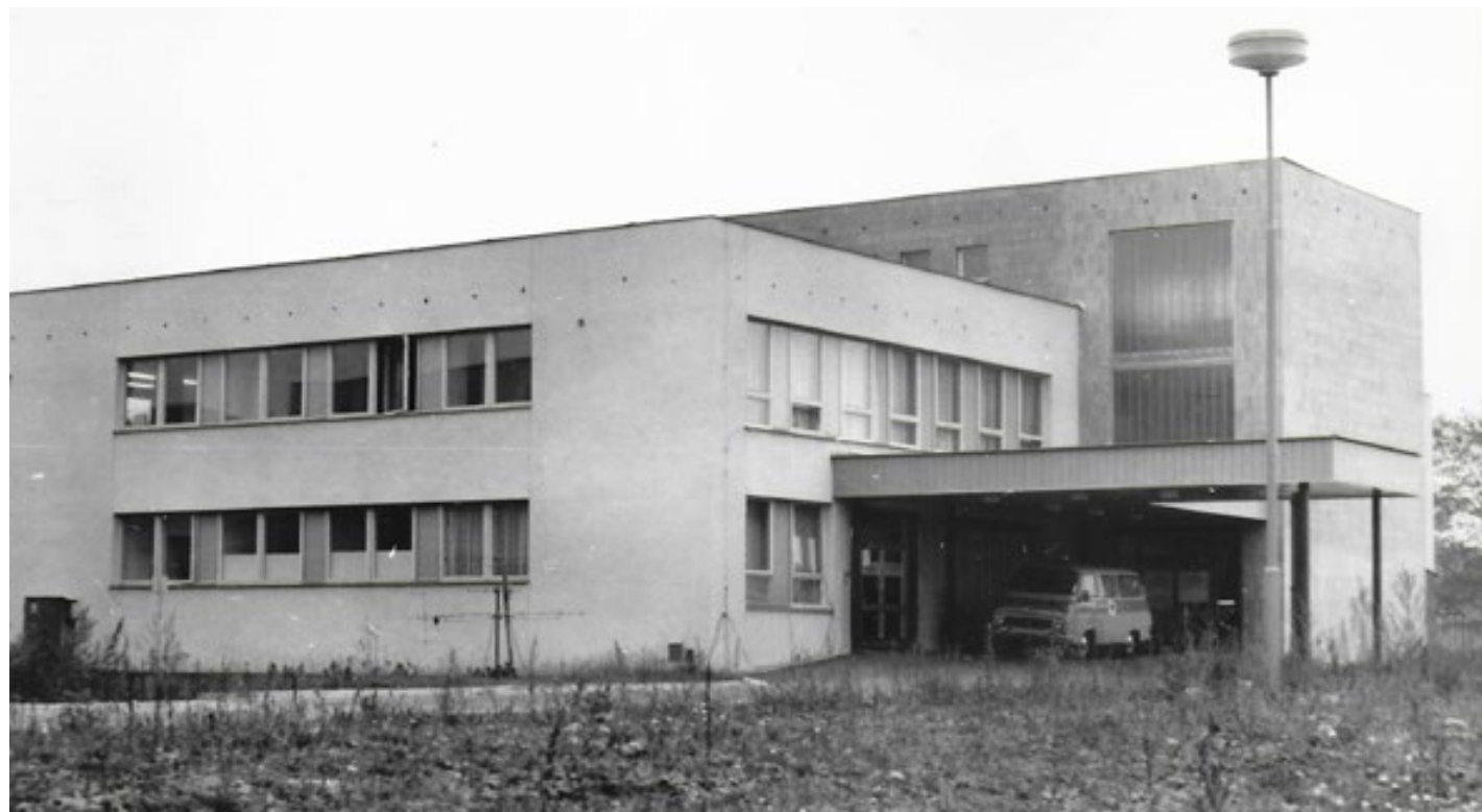
Slavnostní předání nového pavilonu anesteziologicko-resuscitačního oddělení Nemocnice s Poliklinikou Šumperk, 16. června 1982, stávající pavilon D.
