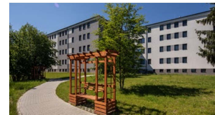
Záložní nemocnice v Zábřehu (dnešní Alzheimercentrum)
